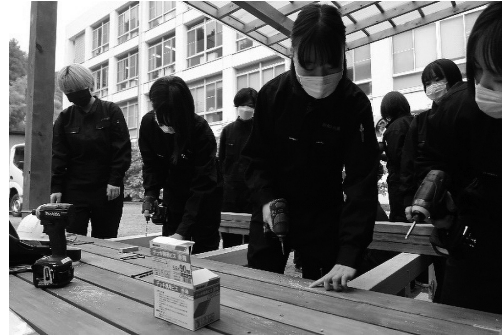
写真21 ウッドデッキ張りの様子
