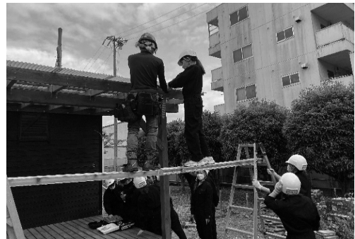
写真22 軒樋工事の様子
