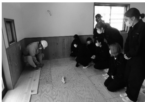
写真13 フローリング張りの指導の様子
