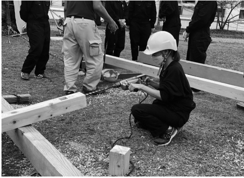
写真19 柱の加工の様子
