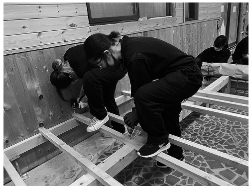
写真 9 根太取付けの様子
