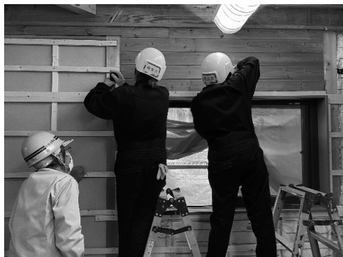
写真11 胴縁取り付けの様子
