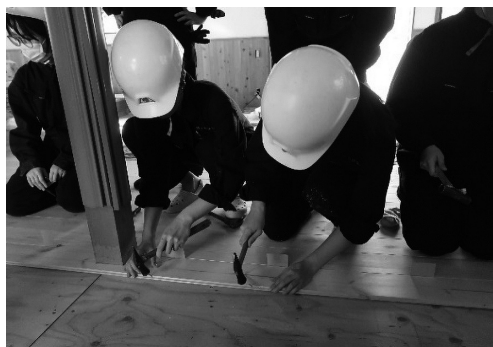
写真14 フローリング張りの様子
