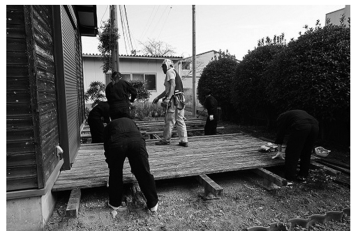
写真6 ウッドデッキ解体の様子
