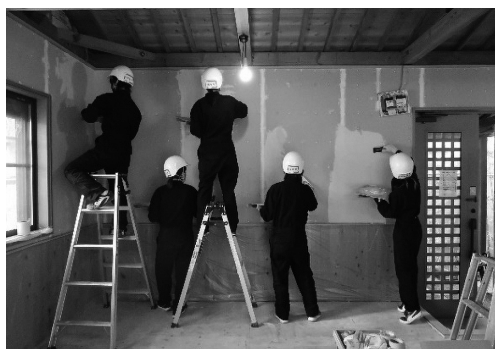
写真12 左官工事の様子
