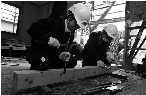
写真 7 床組み木材加工の様子
