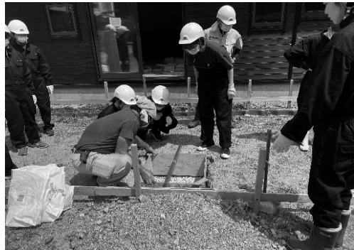
写真18 独立基礎型枠工事の様子
