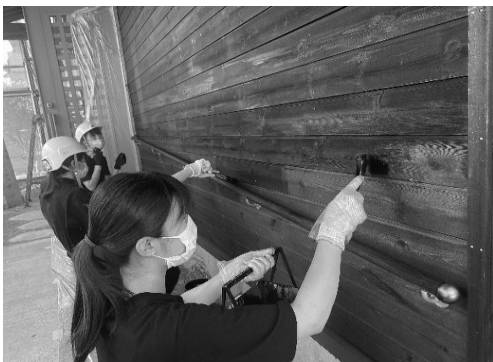
写真16 外壁塗装の様子
