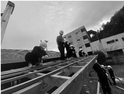
写真20 ウッドデッキ屋根工事の様子
