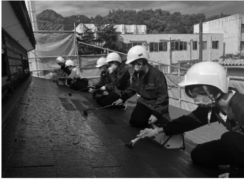
写真15 屋根塗装の様子
