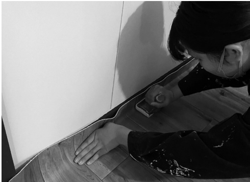
写真19 クッションフロア工事の様子
