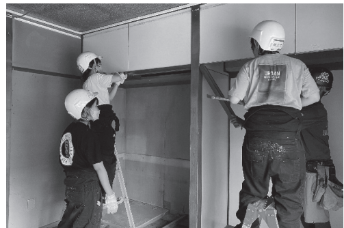
写真14 押し・床の間解体の様子
