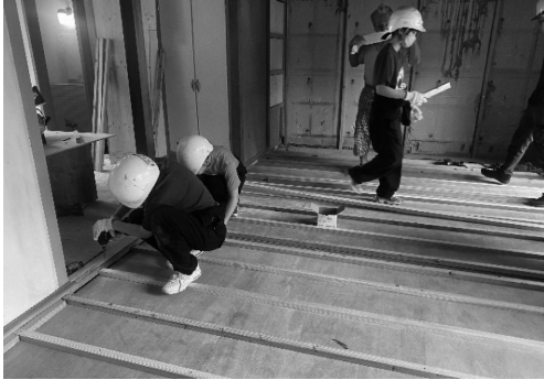
写真15 根太施工の様子
