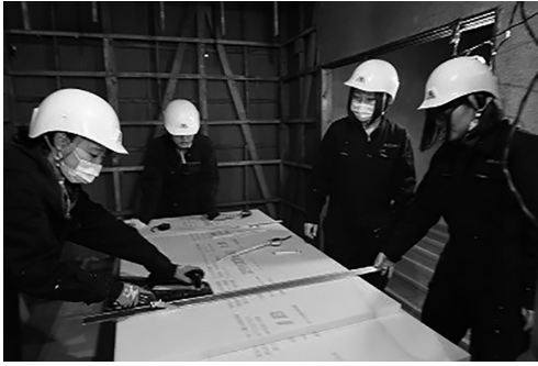
写真8 断熱材カットの様子
