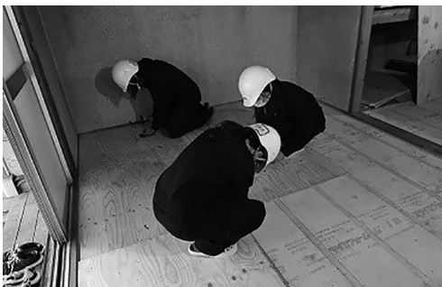
写真10 床下地施工の様子
