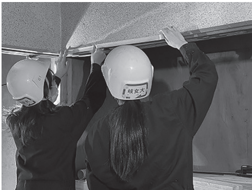
写真12 建具枠養生の様子
