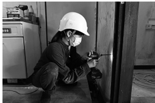
写真9 金物の取付けの様子
