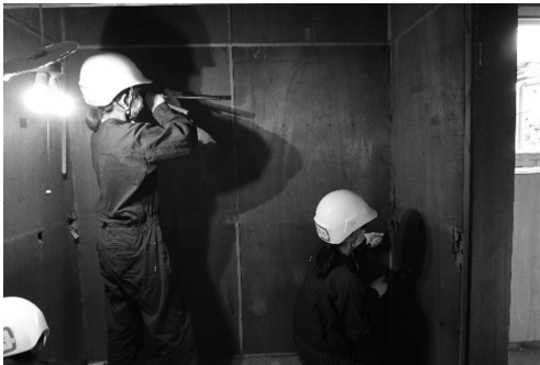
写真6 解体作業の様子1
