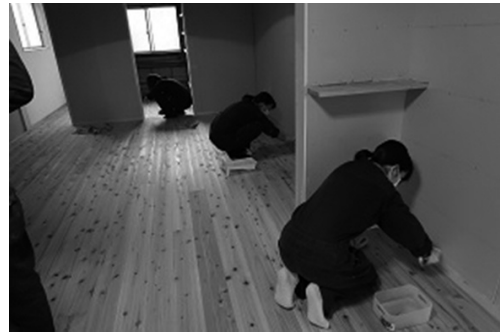
写真17 床塗装の様子 (文責：森田実沙)
