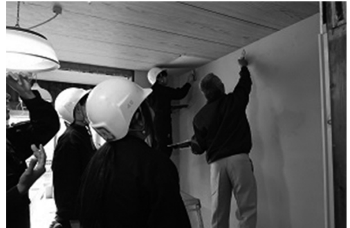
写真13 左官工事の様子1
