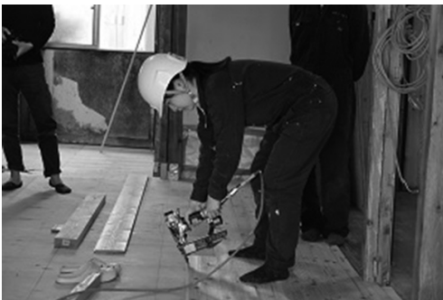
写真12 フローリング張りの様子2
