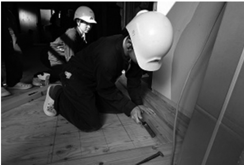
写真11 フローリング張りの様子1
