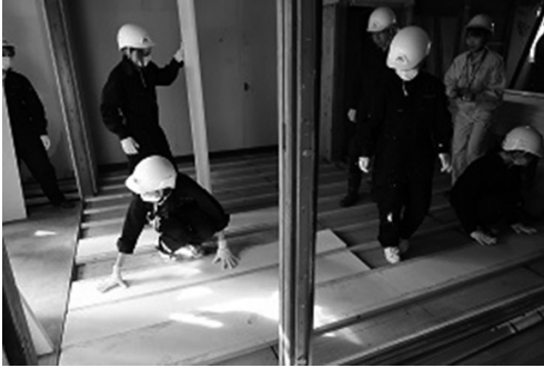
写真10 断熱作業の様子
