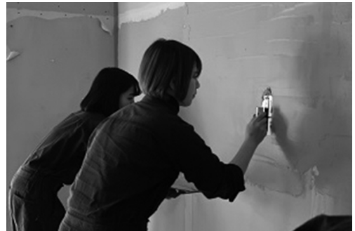
写真14 左官工事の様子2
