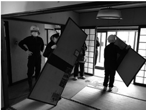
写真7 解体作業の様子2
