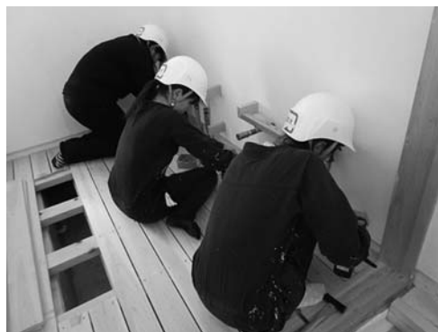
図18 床すのこ製作の様子
