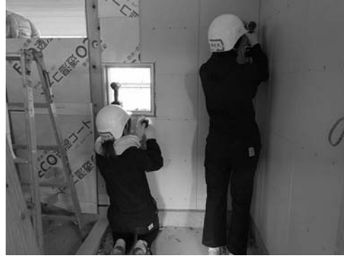
図14 内部サイディングボード取り付け
