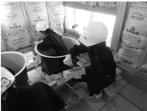
図13 レンガ積みの様子
