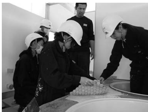
図17 タイル張りの様子
