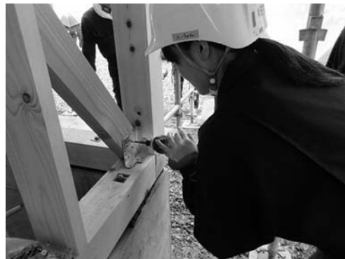
図7 筋交いプレートの取り付け
