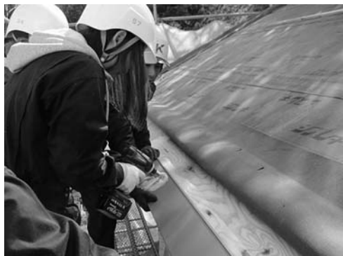
図8 屋根水切りの取り付け
