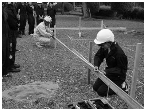
図4 水貫の取り付けの様子
