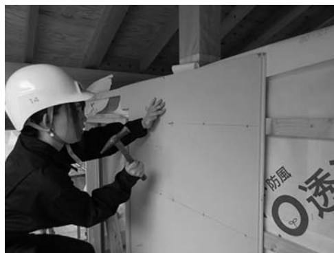
図10 サイディングボードの取り付け
