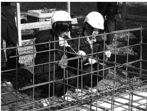
図5 ハッカーを使って鉄筋を結束
