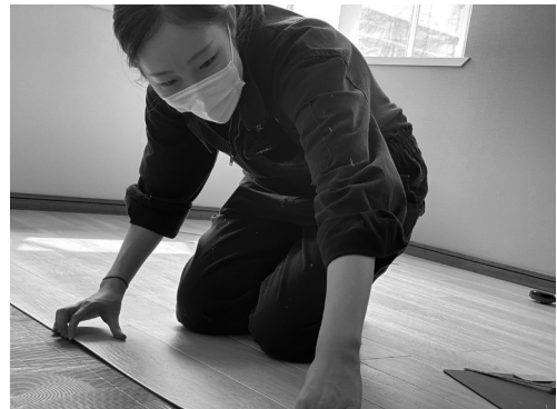
写真22 フロアタイル施工の様子2
