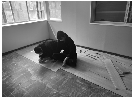
写真21 フロアタイル施工の様子1
