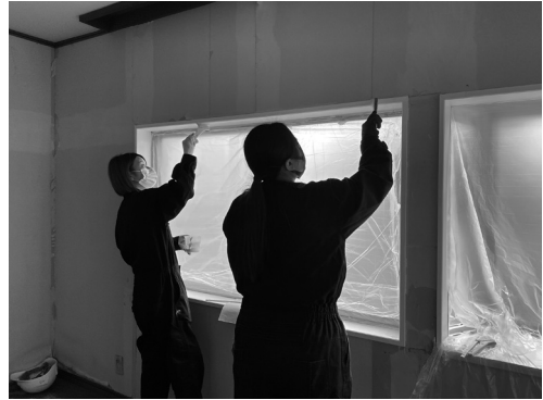
写真12 窓枠塗装の様子
